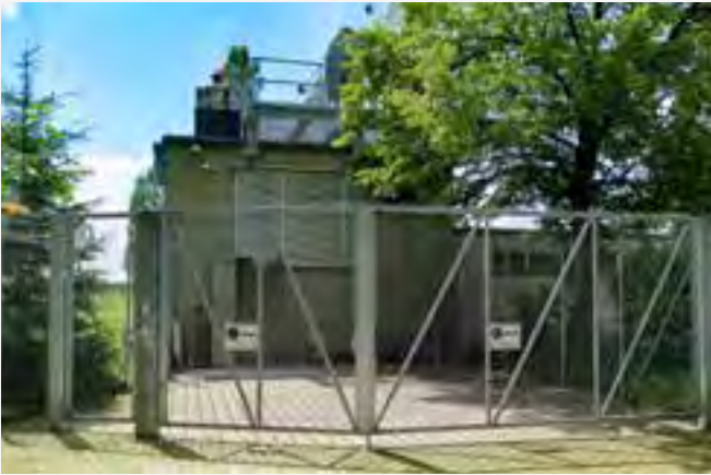
Das Hochsicherheits-Datacenter in Uitikon der GIB-Solutions AG
