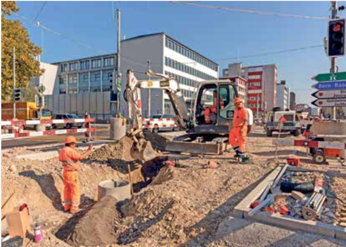
Die Bauarbeiten gehen zügig voran
