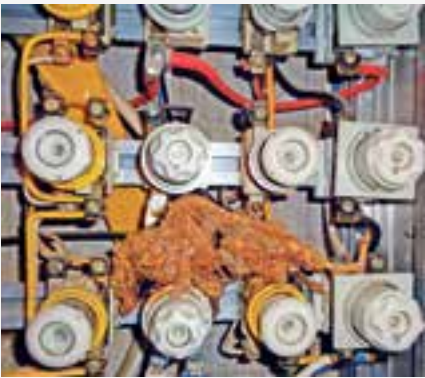
Verbranntes Tier in der Elektroverteilung, akute Brandgefahr!
