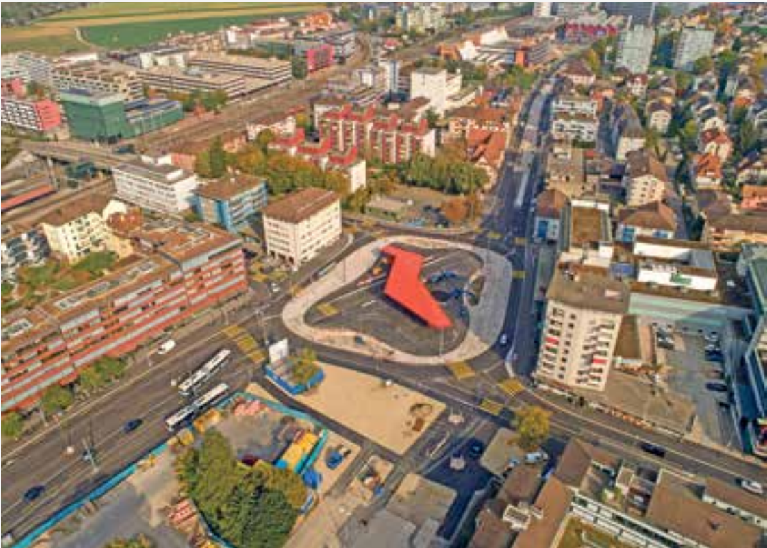
Der neu gestaltete Stadtplatz mit Nebelbrunnen und Flügeldach
